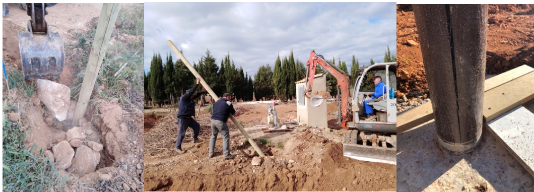
Figura 3: Colocación de postes en el viñedo. Detalle de falcado de postes con rocas y hormigonado. 3
